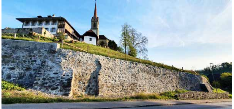
Erneuerte Stütz- mauer auf der Südseite.
