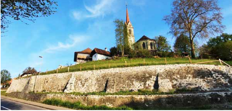
Erneuerte Stütz- mauer auf der Südostseite.
